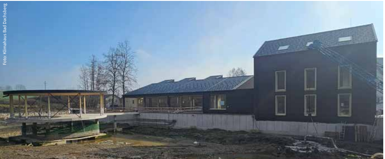
Die Bauarbeiten beim Klimahaus Bad Dachsberg schreiten rasch voran.
