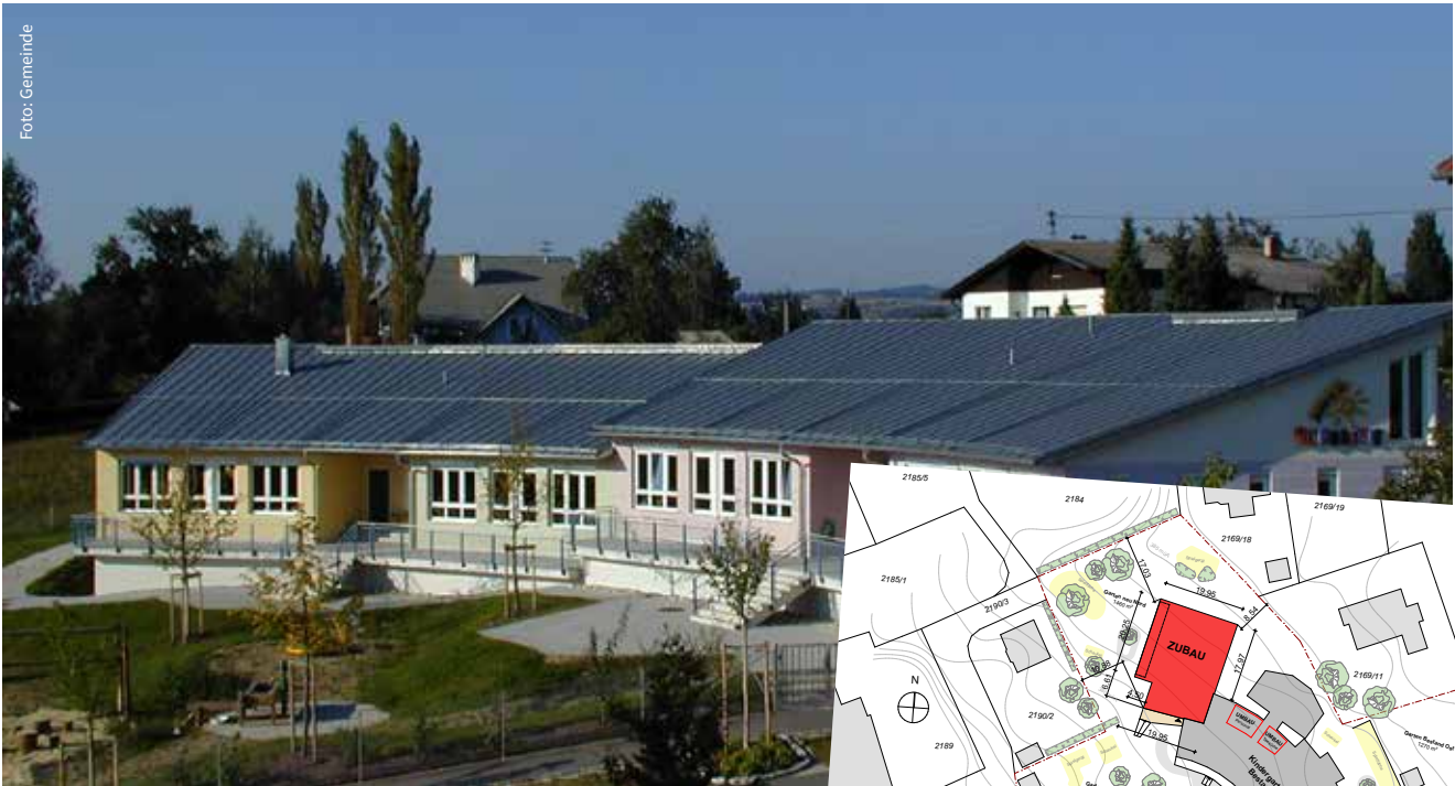
Zubau am Kindergartengebäude
