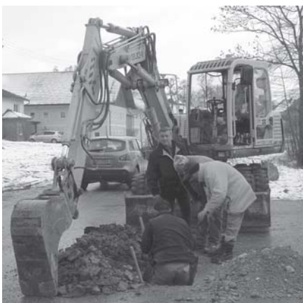
Wasserleitungsbau in Unterprambach
