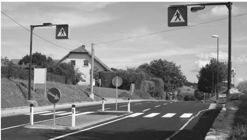
Der Fußgängerübergang über die B 129 wurde neu abgesichert.
