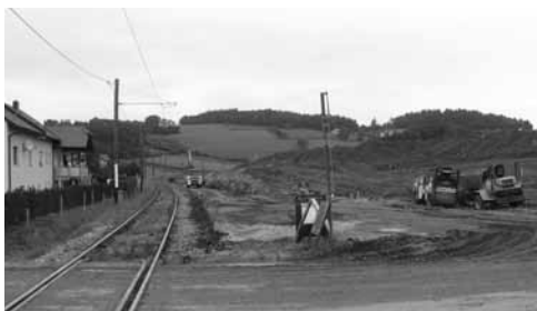
Betriebsausweiche und Vergrößerung des Pendlerparkplatzes in Prattsdorf
