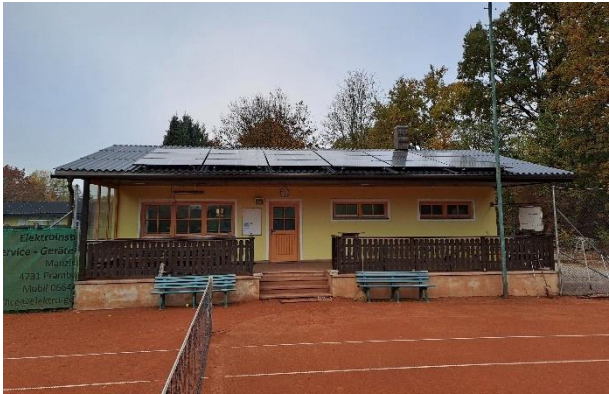
Tennisplatz, 12,3 kWp, Energy Technics
