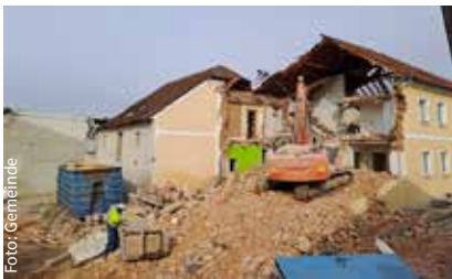
Foto: Gemeinde Abbrucharbeiten
